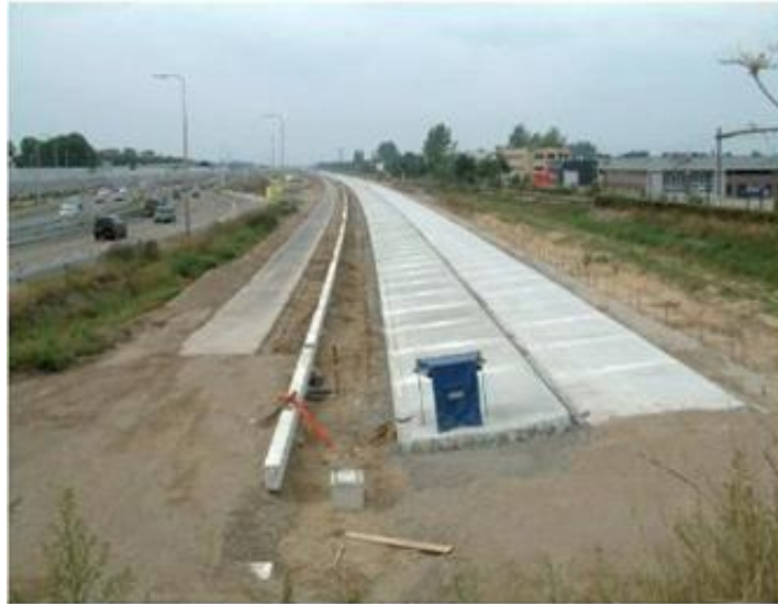
De aanleg van de hoge snelheidslijn. De verkanting in de bocht is goed te zien.
